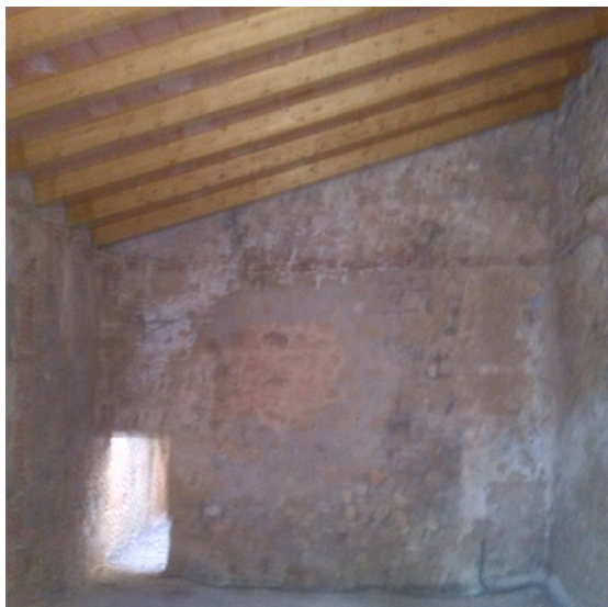
Fig. 16. Detall del interior de l'Ermita d'Orta de Sant Joan que alberga l'estació sísmica ERTA de l'IGN i l'estació magnètica de l'OE un cop reconstruïda la teulada ensorrada. Detalle del interior de la Ermita de Orta de San Juan que alberga la estación sísmica ERTA del IGN y la estación magnética del OE una vez reconstruido el tejado hundido.
