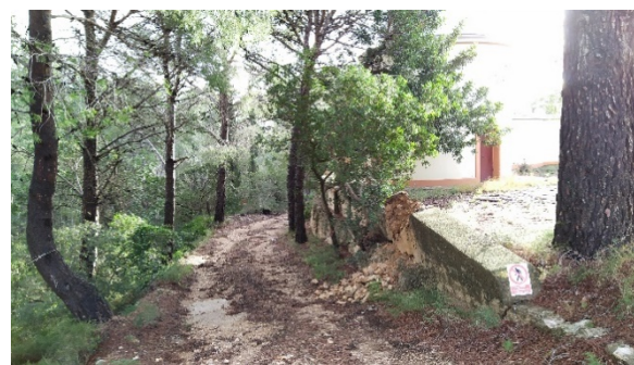
Fig. 14. Detall dels desperfectes en un dels murs de contenció causats pel temporal Glòria. Detalle de los desperfectos causados en uno de los muros de contención causados por el temporal Gloria.
