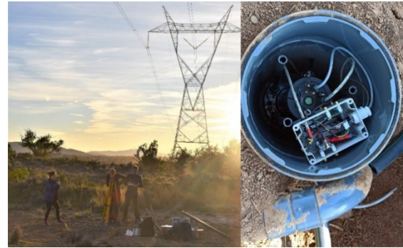
Fig. 3. Mesura dels efectes magnètics dels GIC sota la línia elèctrica de 400 kV que uneix les subestacions de Vandellòs i la Plana a la província de Castelló. Medición de los efectos magnéticos de las GIC bajo la línea eléctrica de 400 kV que une las subestaciones de Vandellòs y La Plana en la provincia de Castellón.
